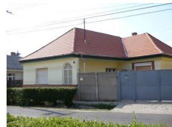
Kesztölci Népi építészet-arculat
